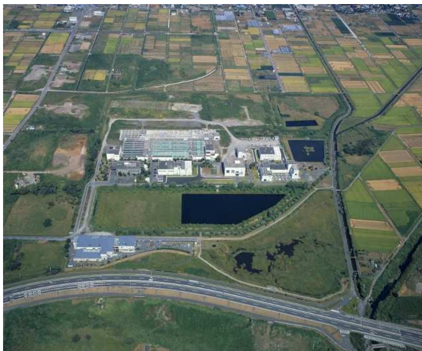
狩野川西部浄化センター
