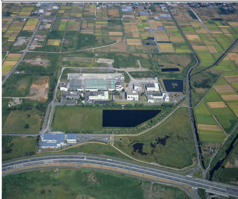
狩野川西部浄化センター
