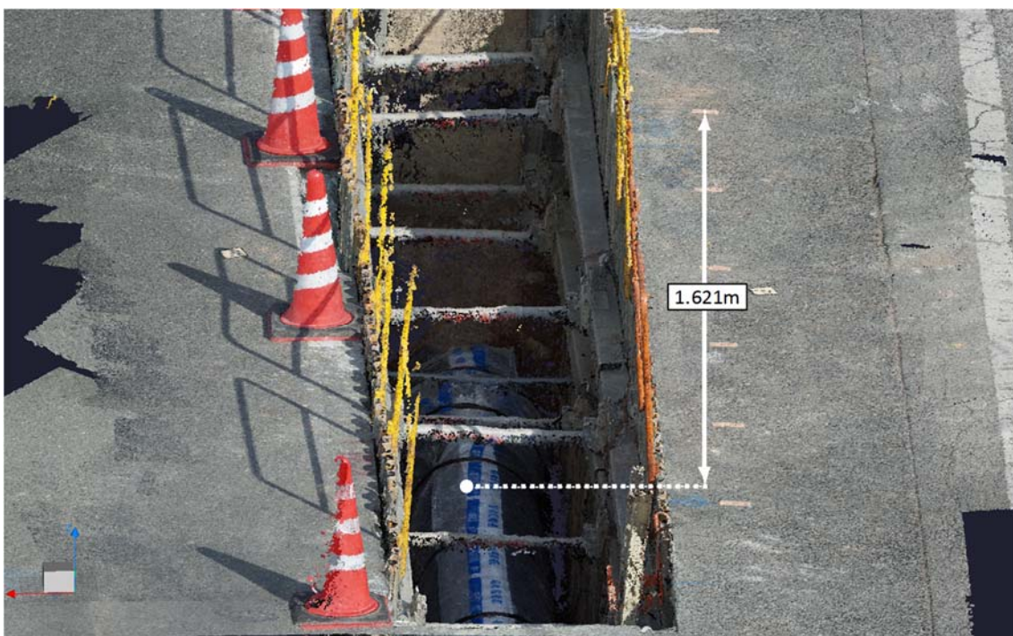
図 出来形計測位置（寸法値）の一覧（作成例）
