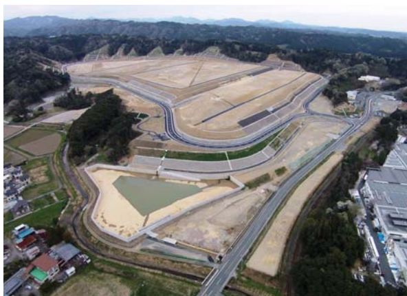
写真 12 新東名高速道路 SIC に近接する工業団地
