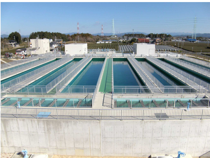
遠州水道 寺谷浄水場
