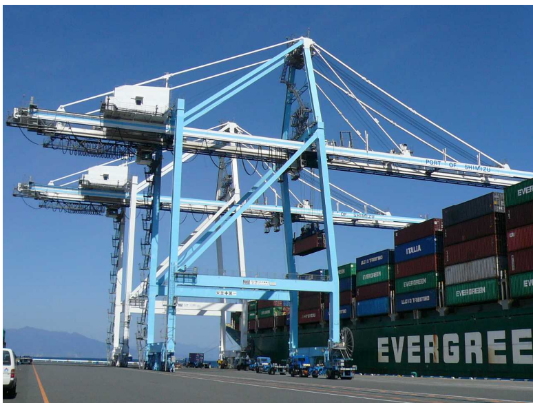
新興津埠頭ガントリークレーン
