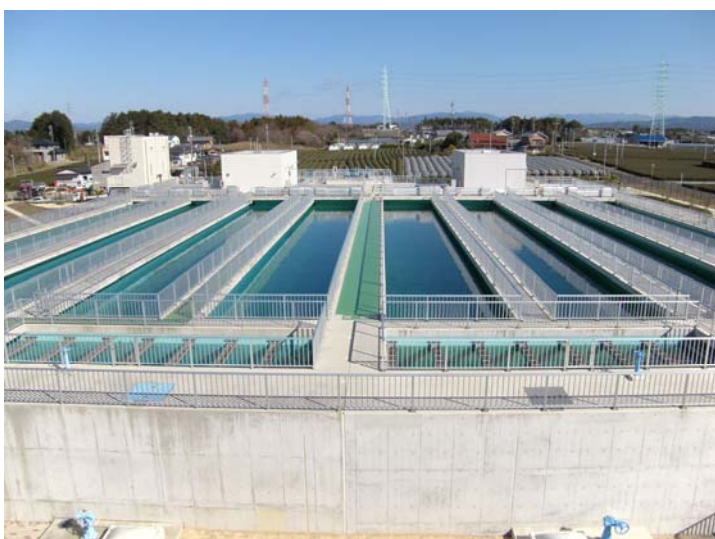
遠州水道 寺谷浄水場
