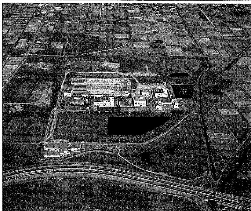
狩野川西部浄化センター
