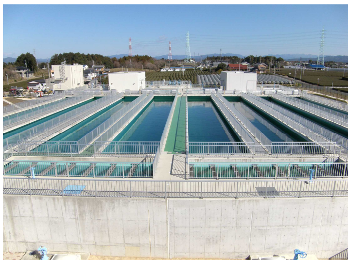
遠州水道 寺谷浄水場
