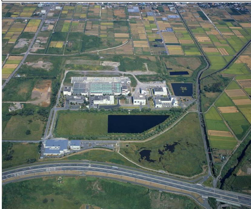
狩野川西部浄化センター
